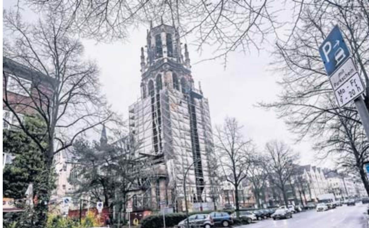
Die Sanierungsarbeiten an der Herz-Jesu-Kirche reihen sich in eine lange Liste. Wegen Einsturzgefahr war das Gotteshaus an der Roßstraße 2001 sogar für vier Jahre geschlossen worden.
